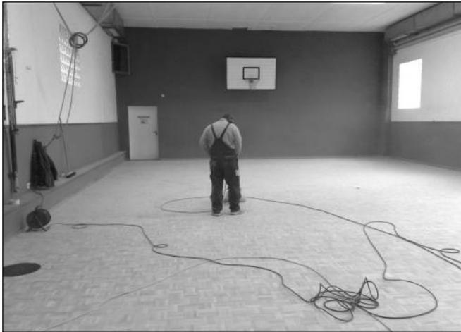
Nach 16 Jahren Sportbetrieb mit dem Hallenboden stand zwischen den Jahren 2007/2008 mal wieder eine Fußbodensanierung an. Der Boden wurde abgeschliffen und neu versiegelt. Kosten ca. € 6500.-
